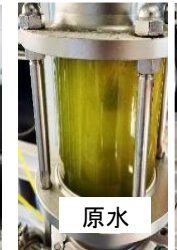
原水・処理水の配管ライン 給入出水管理サイトグラス
